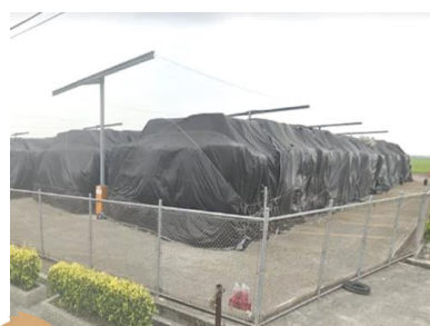
回收紙堆疊已設置護網等防止倒崩塌的設備
